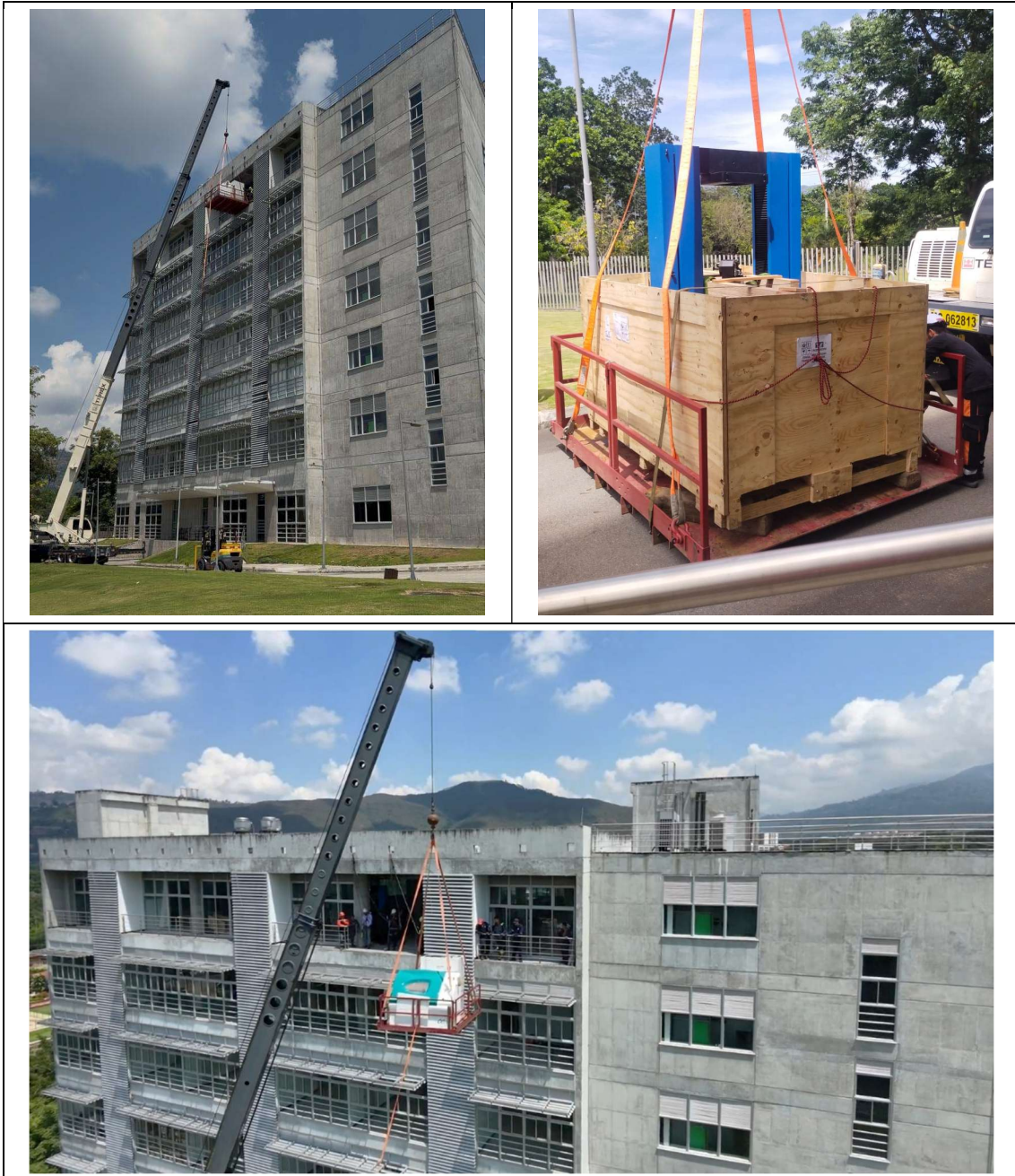
Figura 5. Maniobras de Izaje de Equipos – Parte I.
