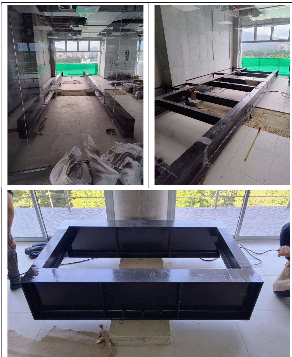
Figura 3. Trabajos de Reforzamiento Estructural
