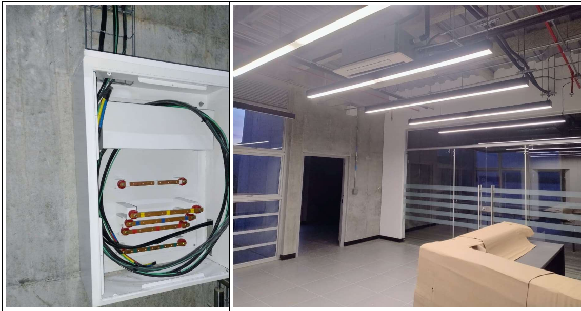
Figura 2. Avance en Adecuaciones Eléctricas e Iluminación
